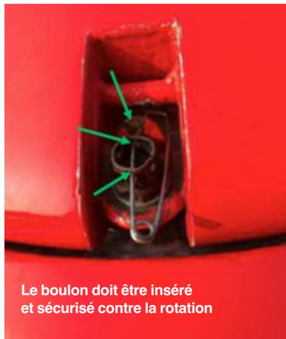
Le boulon doit être inséré et sécurisé contre la rotation
